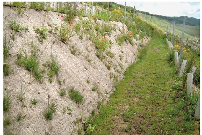
Erosionsschutzmatte mit Polypropylen-Trägernetz in neu angelegten Querterrassen im Weinberg. (Foto: Hubert Laufer)
